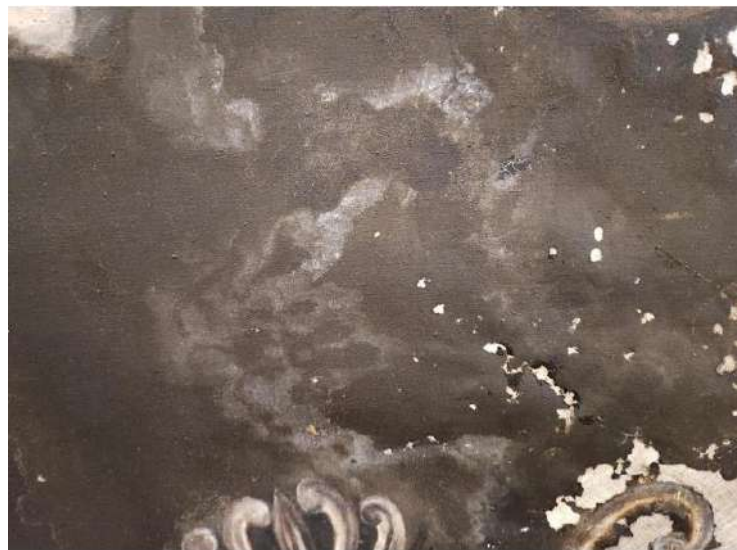
Détails des sels cristallisés présent sur la surface.
